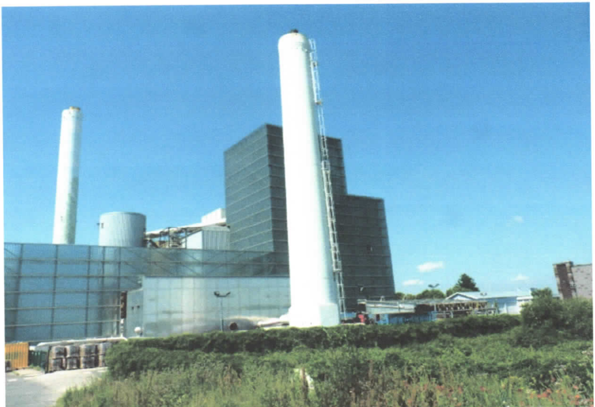
Vue de l'usine de CRISTAL ECO CHALEUR située au 2 rue de l'Union à Carrières sur Seine
