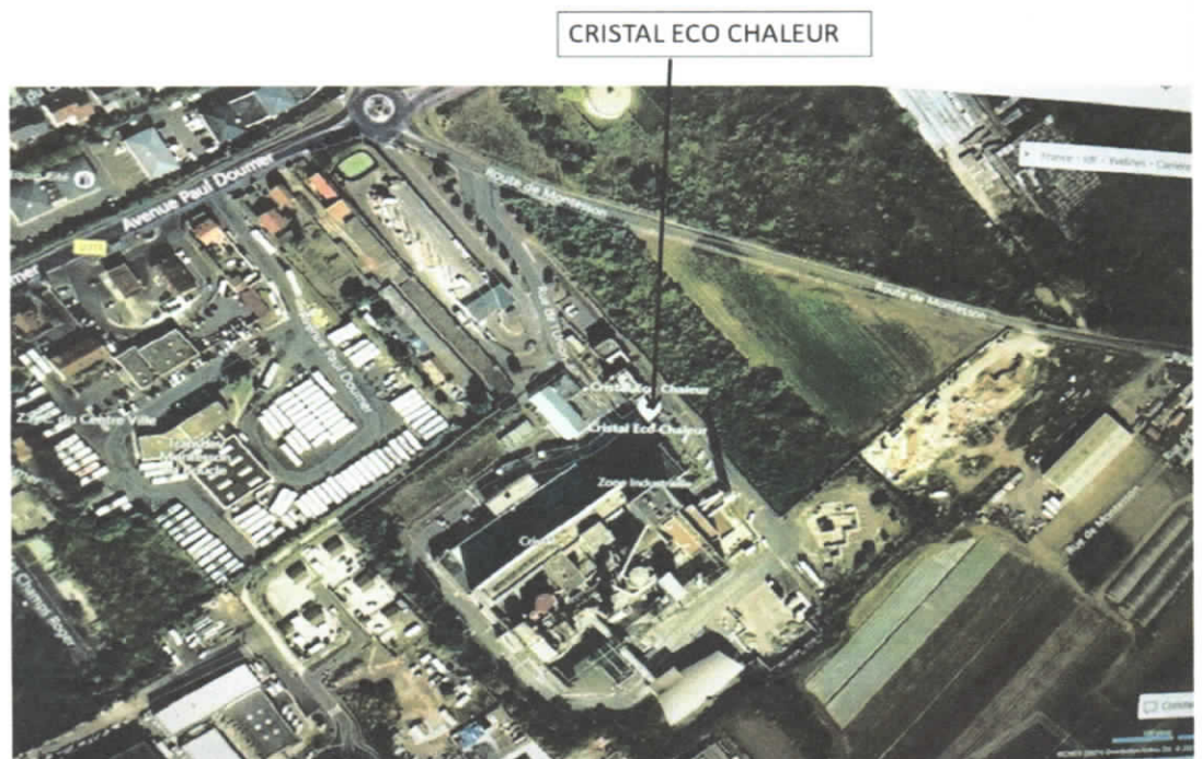
Vue aérienne des installations de la société CRISTAL ECO CHALEUR sur le site de SITRU
