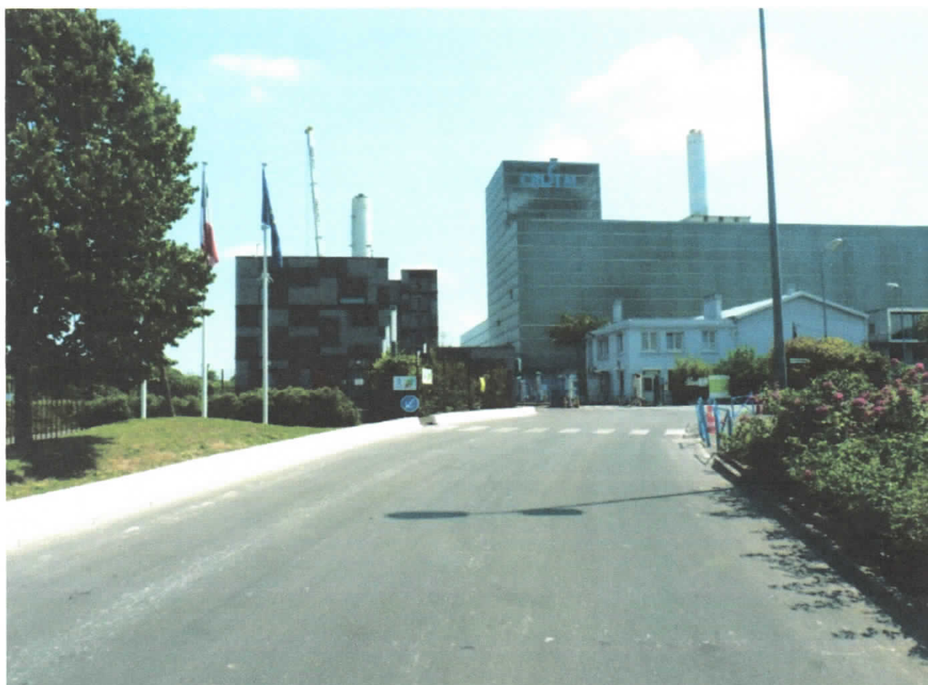
Vue de l'usine de CRISTAL ECO CHALEUR située au 2 rue de l'Union à Carrières sur Seine
